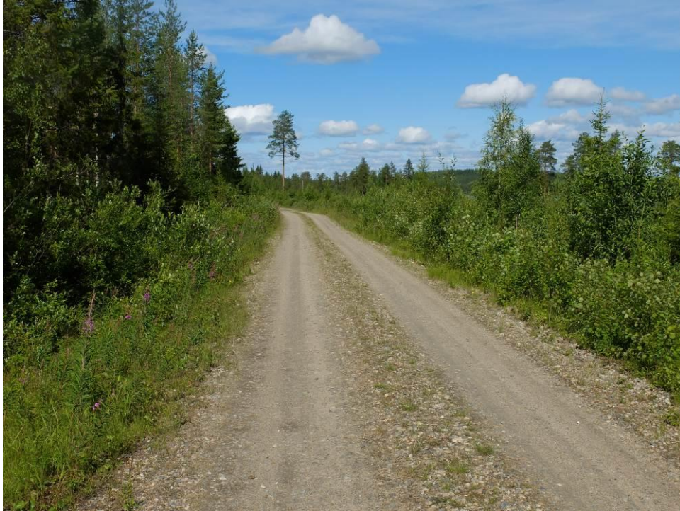
Kuva 21 Tiestöä on ajoittain parannettava. Kuva Häyrysen länsipuolen tiestä
