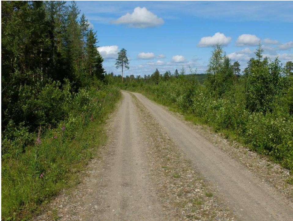
Kuva 24 Tiestöä on ajoittain parannettava. Kuva Häyrysen länsipuolen tiestä
