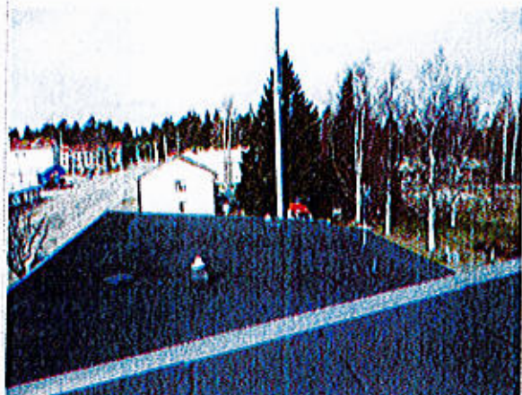
Ristijärven kunnantalon vesikattoa.
